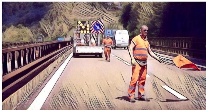
**Chiusura della corsia di sorpasso: posa dei coni dopo la posa della testata di cantiere di chiusura della corsia di sorpasso**
