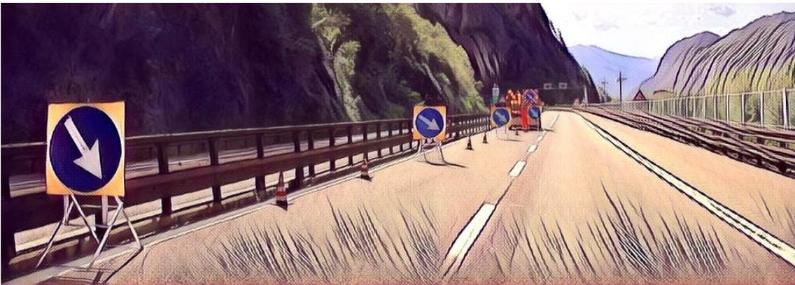
**Chiusura della corsia di sorpasso: installazione della testata di chiusura della corsia di sorpasso**
