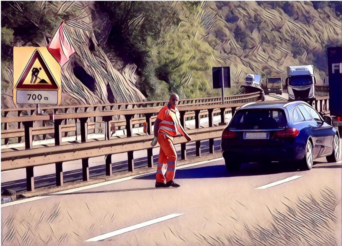
**Chiusura della corsia di sorpasso: attraversamento di ritorno dopo l'installazione del segnale sul margine sinistro**
