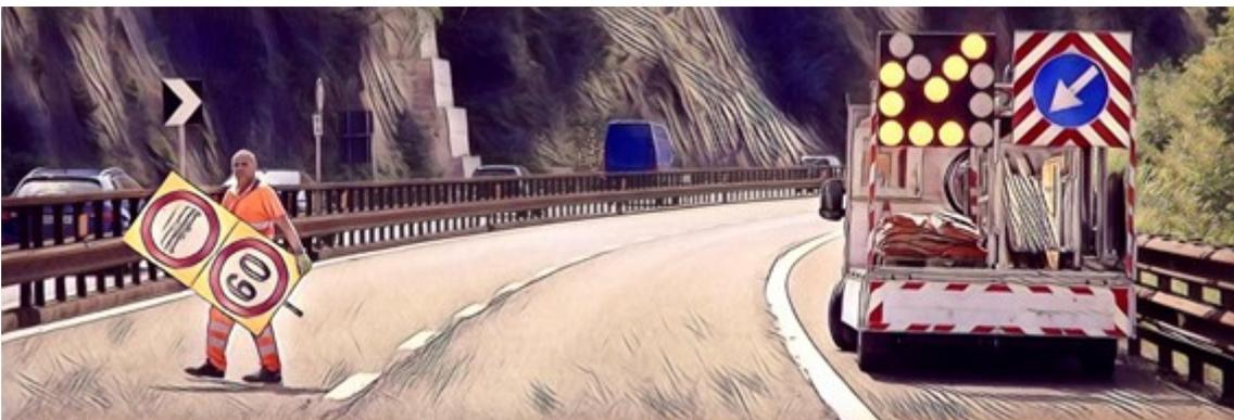
**Chiusura della corsia di sorpasso: attraversamento per installazione del segnale sul margine sinistro**
