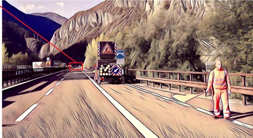
**Eventuale ulteriore presegnalazione degli operatori che installano la testata in corsia di sorpasso tramite sbandieratore posto all'interno dello spartitraffico centrale o a ridosso del sicurvia centrale**
